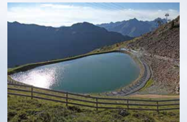
Von oben: Propellerschnee- erzeuger, Pumpstation, Speicherteich Idalp Hintergrund: Schneilanze
